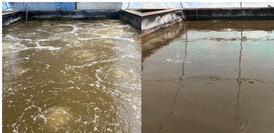
Vista de tanques con sistema de aireación activado (izquierda) y sin sistema de aireación (derecha).
