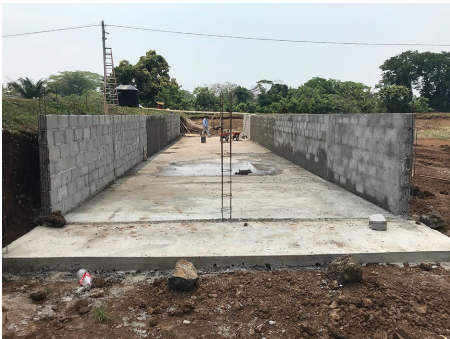
Vista del raceway en estanque durante la construcción. Note el piso de cemento fijo en el fondo del estanque.
